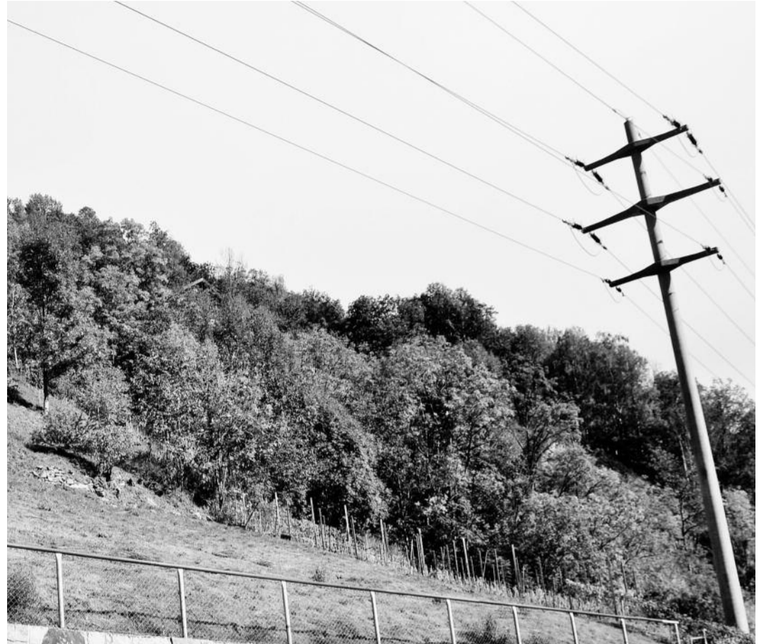
Bauhindernis. Die 65-kV-Leitung Ackersand-Täsch führt durch das Grundstück von Bernhard Willisch.
